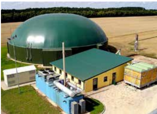
Мал. 97. Біогазова установка (Київська область)
